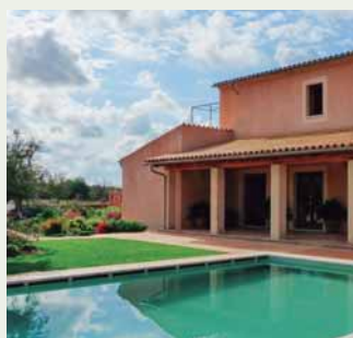
Rénovation d'une villa passive haut de gamme «Proyecto Tierra» à Llucmajor, Majorque (Espagne). Aquarea
