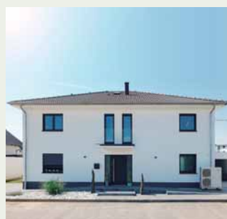
Villa dans un nouveau lotissement à Bruchköbel (Allemagne). Aquarea
