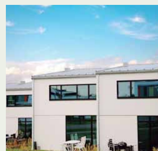
75 maisons à faible consommation d'énergie à Hasselager (Danemark). Aquarea
