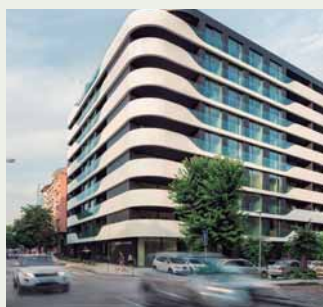
Bâtiment résidentiel exceptionnel en Bulgarie avec une solution CVC efficace. Aquarea
