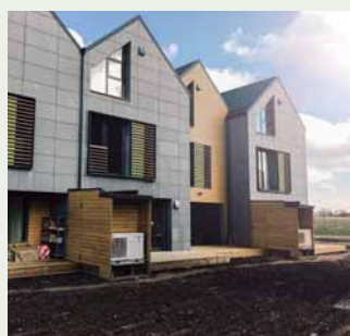
77 maisons à faible consommation d'énergie à 3 niveaux à Vilnius (Lettonie). Aquarea
