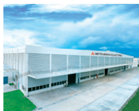
USINE DE CHONBURI EN TAÏLANDE
