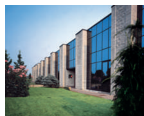
USINE DE PAVIE : IT COOLING
